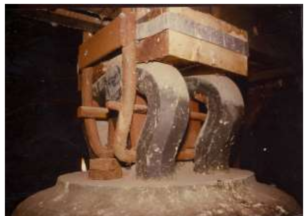
Ersatz eines Kronenhenkels nach Vorbild der erhaltenen Henkel (Fotos: C. Peter)
